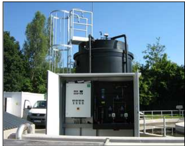
LIKUSTA-Fällmitteldosierstation
