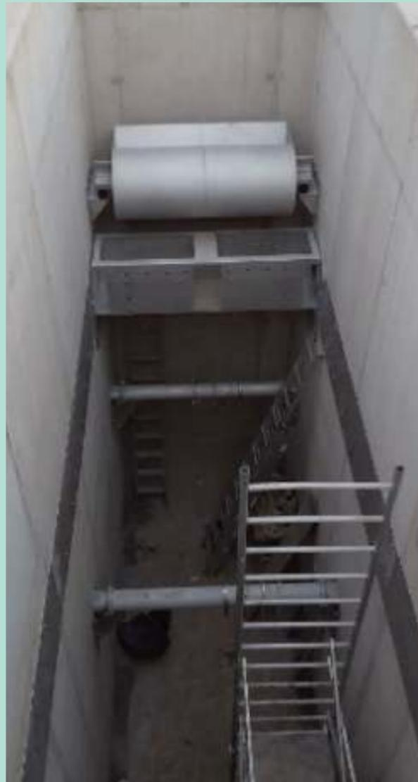
Blick in die Sedimentationskammer eines RKB des K20 Abschnittes der BAB7 in Hamburg (vor Einbau der Schrägklärermodule). Im Hintergrund zu sehen: Spülkippe zur Sohlreinigung des RKB
