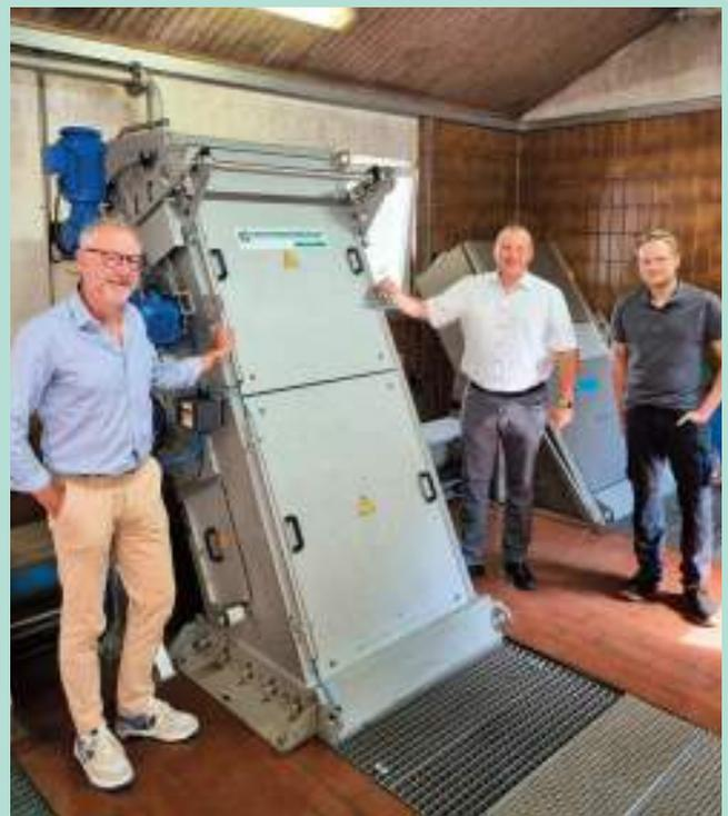
Die Kläranlage verfügt über zwei Zuläufe, um das angekommene Abwasser zu reinigen. Einer der beiden Feinrechen, der die erste Reinigungsstufe in den Kläranlagen darstellt, sollte modernisiert werden, um auch zukünftig den Anforderungen gerecht zu werden.
