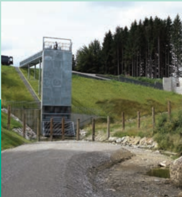
Abbildung 1: HRB Sulzberger Bach, Bayern (II), HydroMaxx® Abflusssteuerung [mi] und Getriebeeinheit[re]
