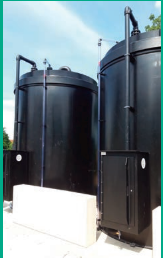
Lagerbehälter mit Befüllstation
